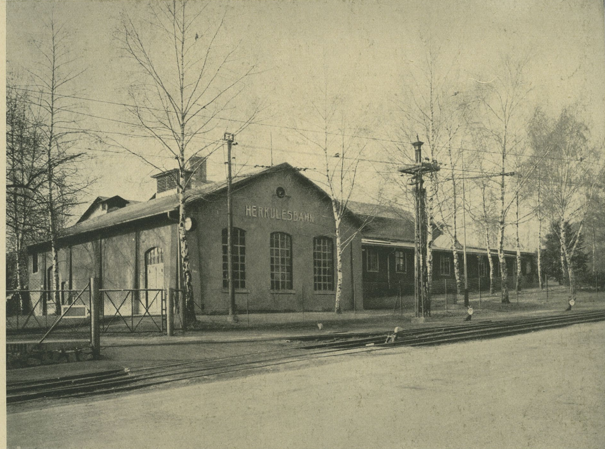
Betriebsbahnhof Dönche (im Vordergrund das Umformerwerk)
