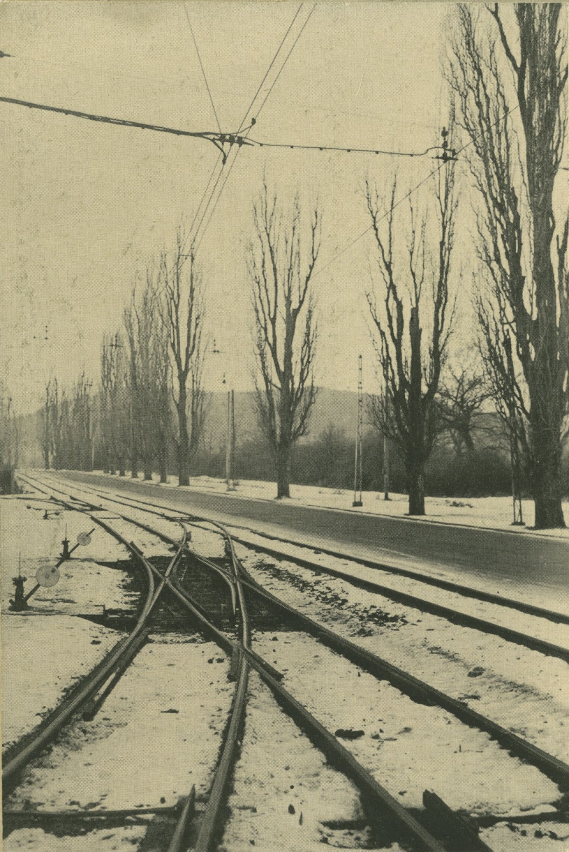
Doppelkreuzungsweiche am Betriebsbahnhof Dönche (in eigener Werkstatt gebaut)
